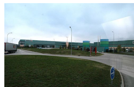
Centre logistique Parc industriel de la Plaine de l'Ain
