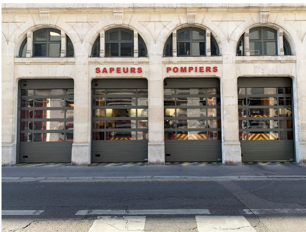
Caserne de sapeurs-pompiers, rue Rabelais (Lyon 3e), ©Benoît Prieur, CCO
