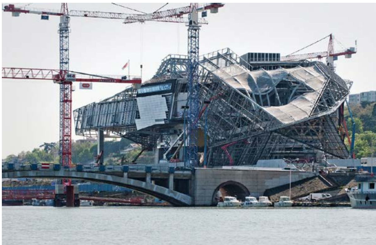
Vue du chantier du musée des Confluences © musée des Confluences – Blaise Adilon
