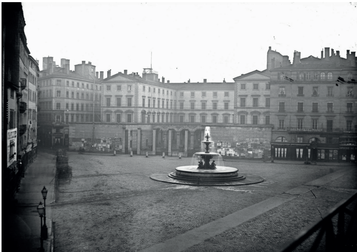
Figure 6 : Hôtel de la Préfecture sur la place de la Préfecture (actuellement place des Jacobins), Fontaine installée place des Jacobins par la Compagnie des Eaux en 1853, photographie noir et blanc sur plaque de verre © AML (1853-1862) – 3PH 440.
