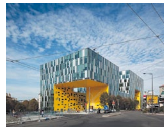
Le Pôle administratif Gruner, construit en 2010 par Manuelle Gautrand qui abrite notamment le siège de la communauté d'agglomération Saint-Étienne Métropole (@Saint-Étienne Métropole).
