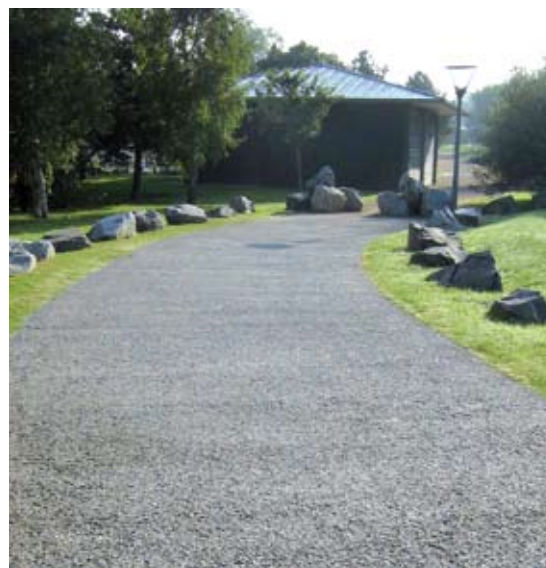
Chaussée en béton poreux
