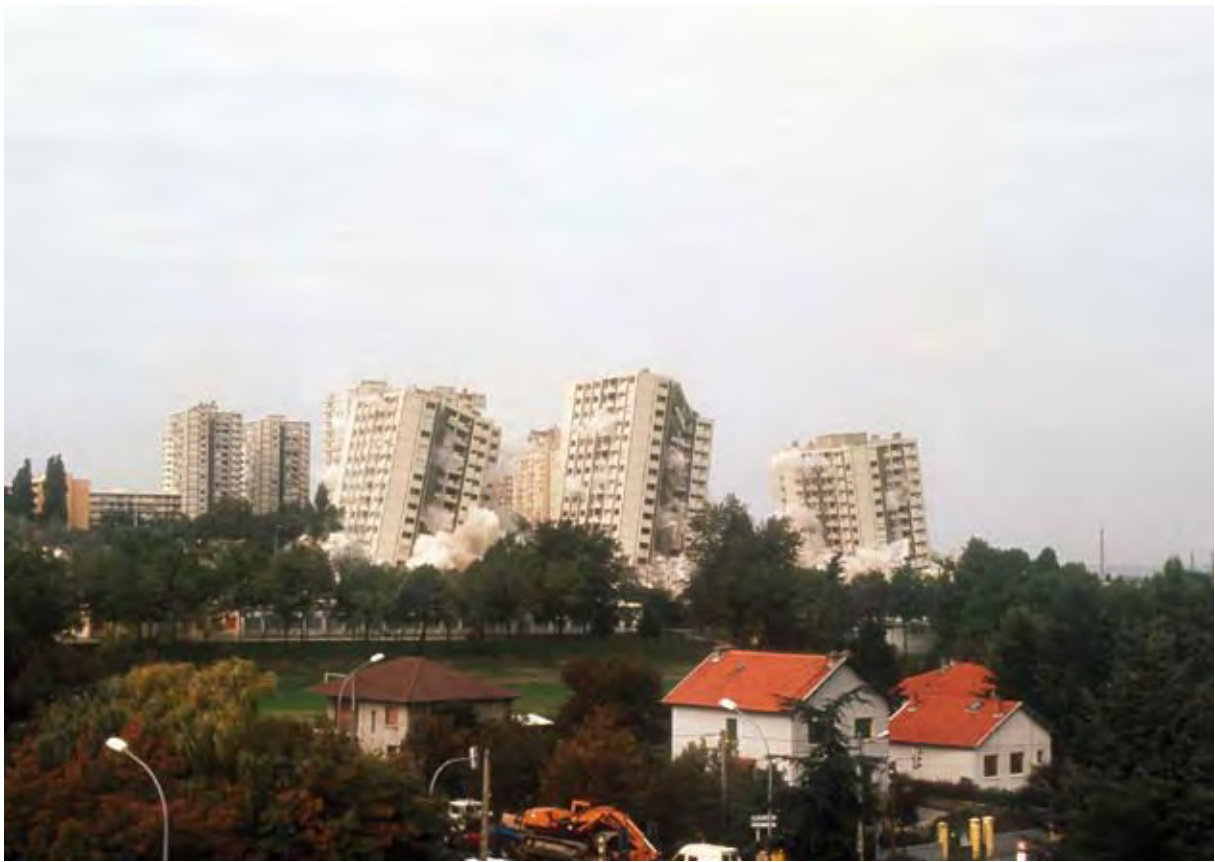
Démolition des tours HLM aux Minguettes à Vénissieux.
