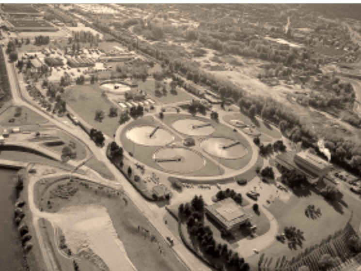
Station d'épuration de Pierre-Bénite
