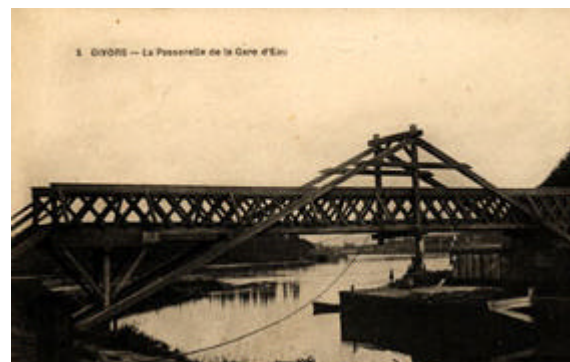
Passerelle, Gare d'eau
