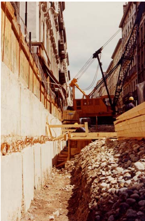
Rue Victor Hugo. Mise en place de parois préfabriquées – SEMALY – CLC
