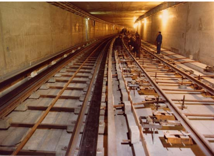
De haut en bas : Rue de la République. Construction du cadre, nappe phréatique et barque – avril 1975 – SEMALY – CLC Vue du pont Morand mixte en construction – avril 1975 – SEMALY – CLC Armement de la voie nouvelle équipée de traverses métalliques – février 1978 – SEMALY - BUIRET
