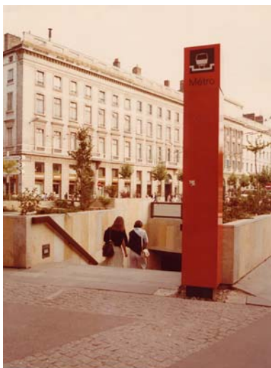
Accès station Bellecour – juin 1978 – SEMALY BUIRET
