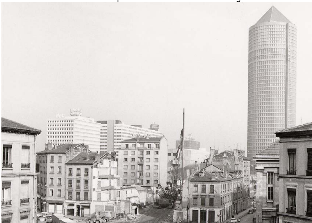
Excavations et mise en place des parois préfabriquées sur l'îlot Servient-Boileau-Dunoir-Moncey – février 1980 – SEMALY - BASSET
