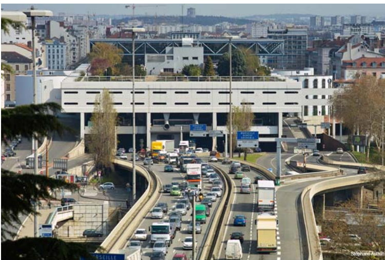
Vue d'ensemble sur la façade Est depuis la colline de Fourvière
