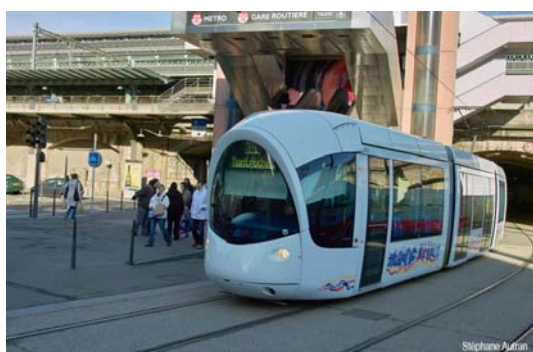
Tramway empruntant le cours Charlemagne en direction du Confluent
