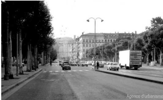
Cours de Verdun avant la construction du centre d'échanges
