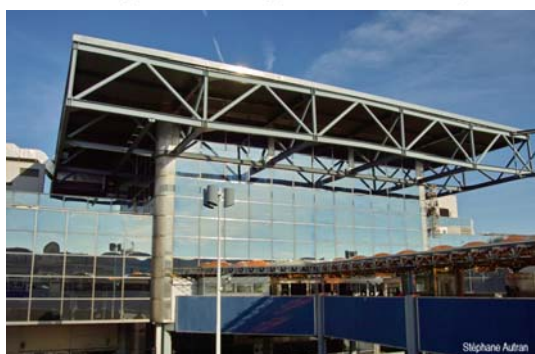
Façade Sud du centre d'échanges et passerelle piétonne vers la gare de Perrache
