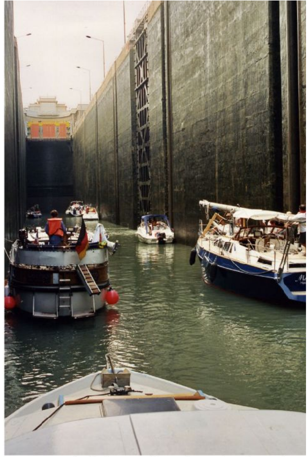
Passage de l'écluse par des embarcations de tourisme
