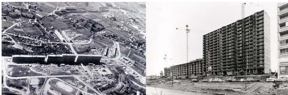
La Duchère en construction - www.gpvlyonduchere.org
