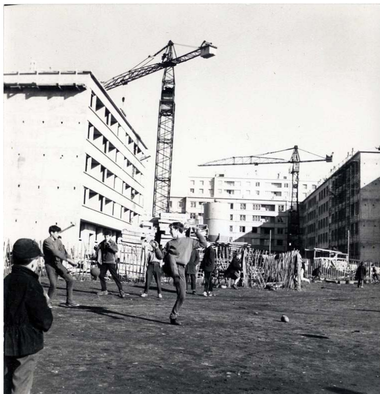
La construction de la Duchère : pendant les travaux, le foot continue... (BM de Lyon - Fonds Marcelle Vallet)
