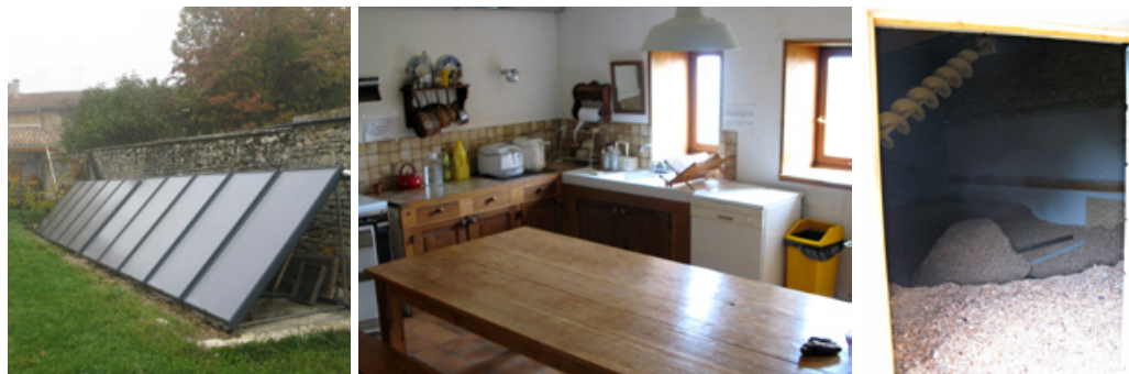
17. Dans la coopérative d'habitants de Anse, A. Liénard branche les lave-vaisselle sur le réseau d'eau chaude, fonctionnant avec des panneaux solaires et la chaudière à bois. D'après ses calculs, cela revient moins cher que de laisser chauffer l'eau par l'appareil. Il transforme ainsi un lave-vaisselle classique en lave-vaisselle écologique fonctionnant au solaire et au bois déchiqueté.
